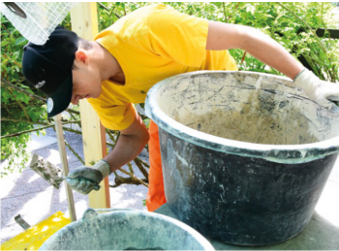
Dylan Stöckle verputzt eine alte Mauer mit Mörtel aus ursprünglichen Materialien.
