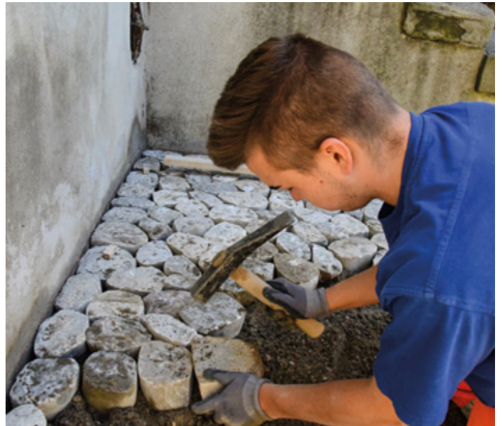
Leandro Goldinger erstellt den alten Gehweg aus Katzenkopfplastersteinen.
