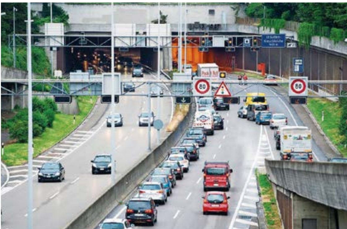
Verkehrseinschränkungen sind während der Bauzeit unvermeidbar.
