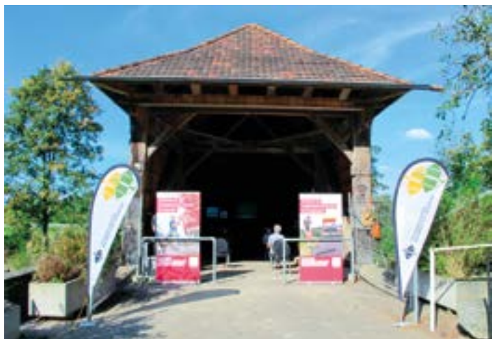
Die Thurvorlandbrücke Zollhaus Bonau-Eschikofen.
