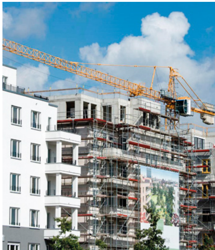
Beispiel für verdichtetes Wohnen: Bauen, wo schon Infrastruktur vorhanden ist.
