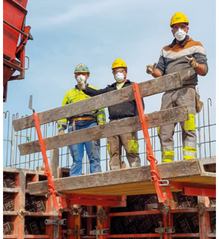
Abstand halten und Schutzmasken auf Baustellen.
